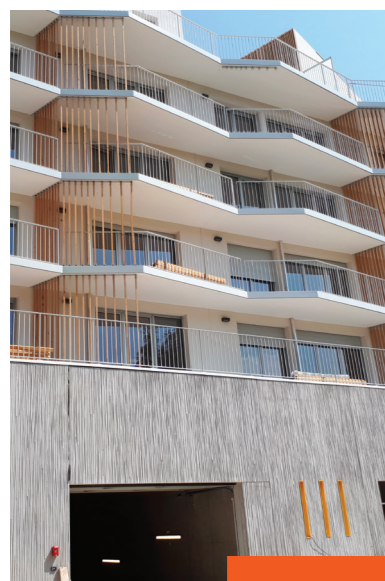
Chantier de Noisiel
